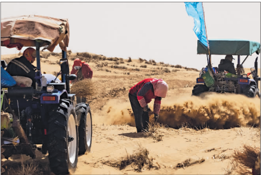
4月12日,在腾格里沙漠工程固沙项目区,中铁四局城轨分公司的植树工人跟着打坑机将花棒种植在草方格中。
