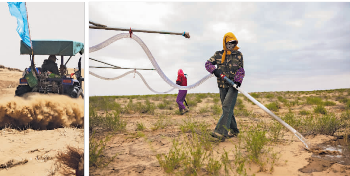
4月12日,在腾格里沙漠工程固沙项目区,中铁四局城轨分公司的植树工人跟着打坑机将花棒种植在草方格中。
